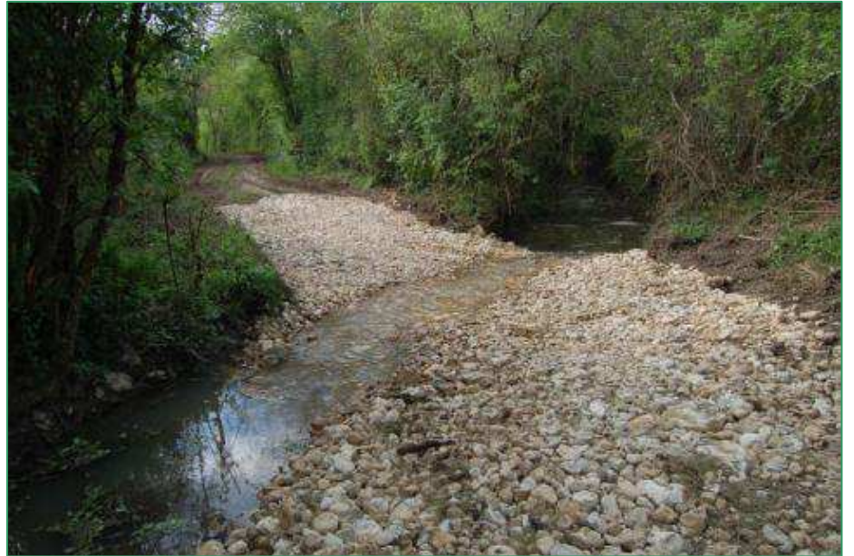
Passage à gué après aménagement
